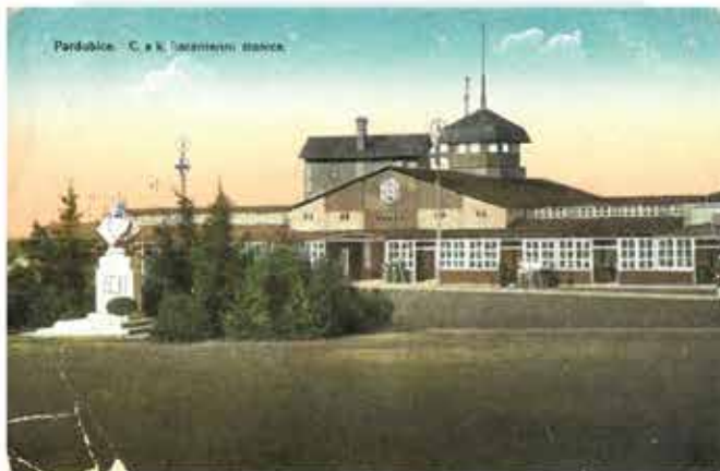
Letní pohled na vojenskou nemocnici v Pardubicích, západní část, pohled z ulice.
