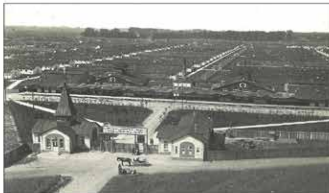
Letní pohled na vojenskou nemocnici v Pardubicích, západní část, pohled z ulice.
